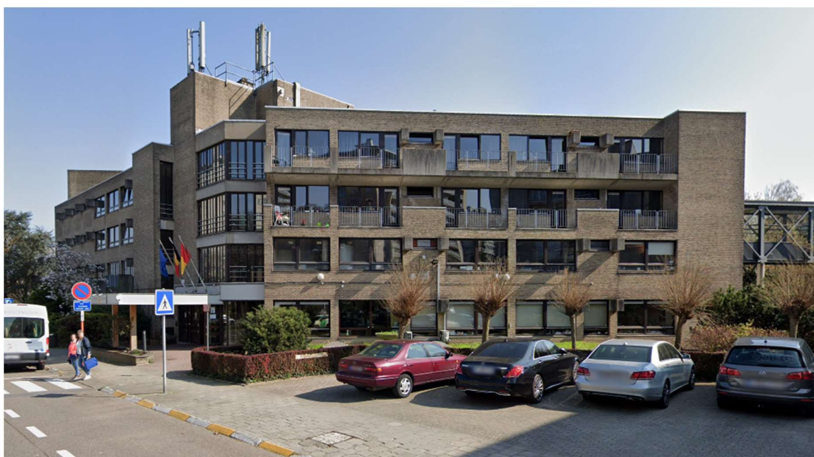
Figure 22: Photographie du Home du CPAS de Ganshoren
