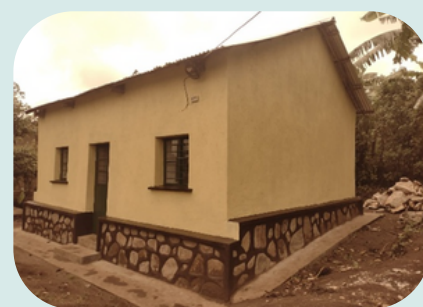
Local de stockage et de réunions des MAMAS de la cellule de Buhimba (mai 2025)
