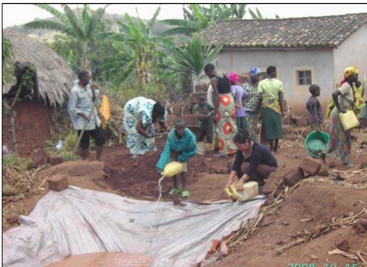
les Amis d'ATD fabriquent les briques en adobe (15/10), à côté d'une maison-hutte en délabrée [à gauche]
