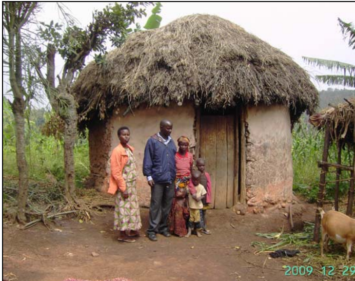
MAISON ANCIENNE telle que vue par Dominique en octobre (le toit n'est pas étanche)
