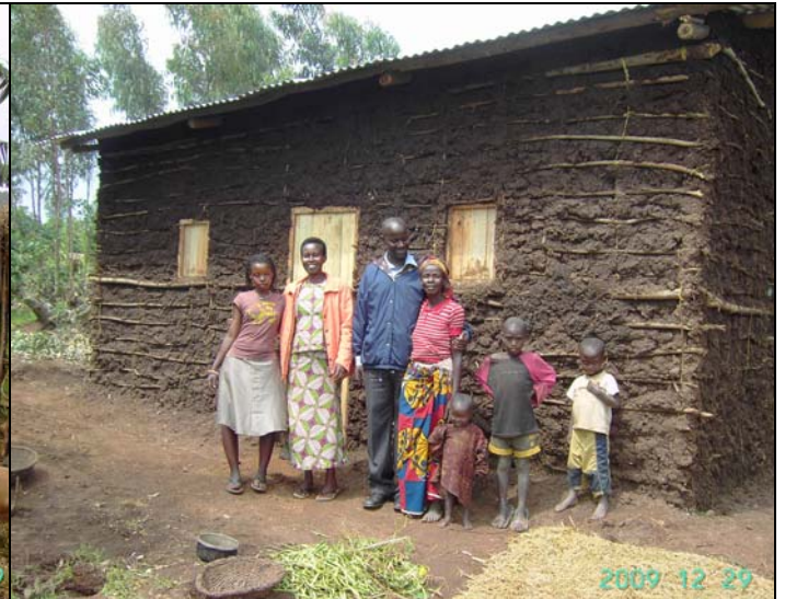
MAISON NOUVELLE occupée à la Noël 2009 Veneranda, David et leur famille (les murs doivent encore être cimentés pour résister à l'érosion)
